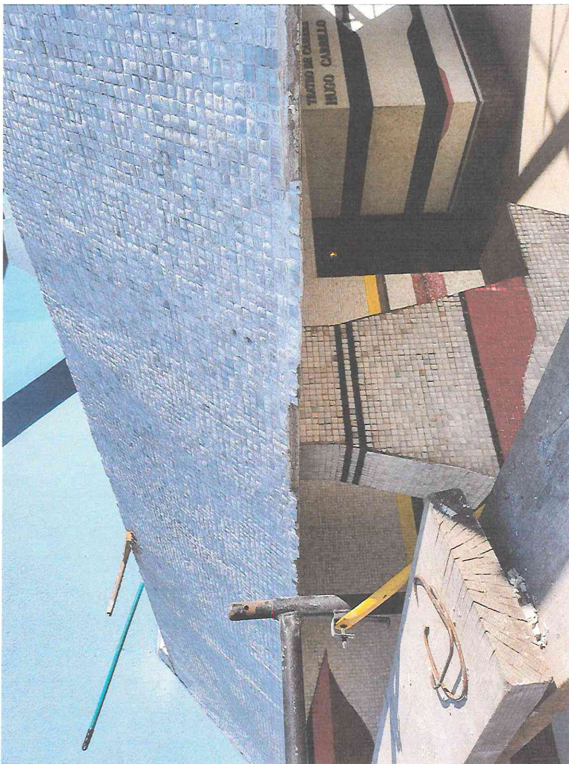
TRABAJOS LIBERACIÓN DE AGREGADOS EN PARTE SUPERIOR DEL INGRESO DEL TEATRO DE CÁMARA – SEGMENTO TC
